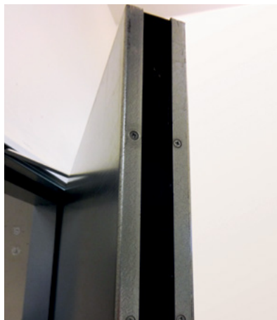
Tôles de couverture vissées
