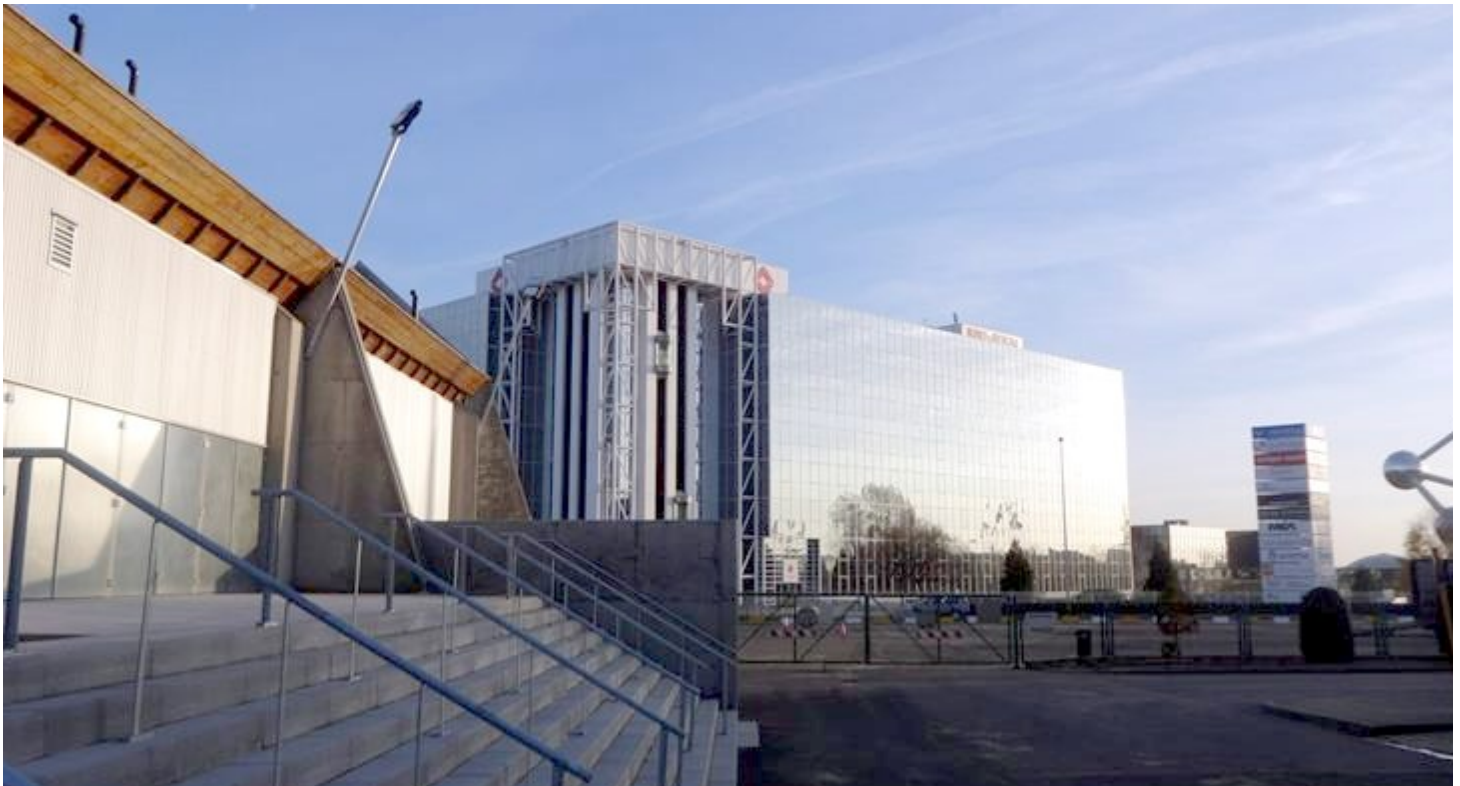
De paniekuitgangen van Paleis 12 in Brussel bijvoorbeeld moeten een veilige doorgang kunnen garanderen in panieksituaties
