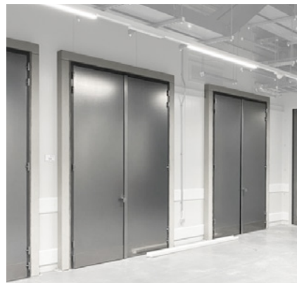
Datacenter / IT Lokaal
